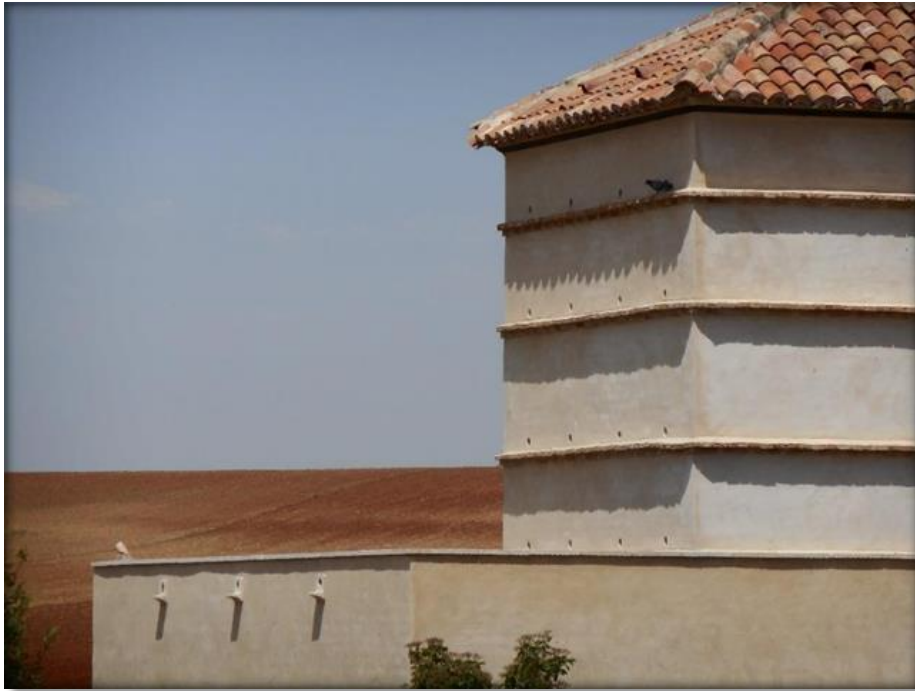
Figura 3: Imagen del primillar de Quer (cara Sur con 16 nidales en la cara del primillar, 3 en el muro y 2 en el tejado y cara Este con tan sólo 2 nidales en el tejado) (Fuente: Google Earth).
